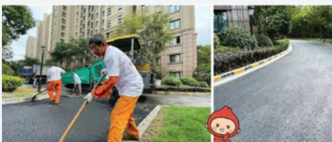
像这个路面，之前是波浪起伏的，中间还有裂缝下沉的比较厉害
